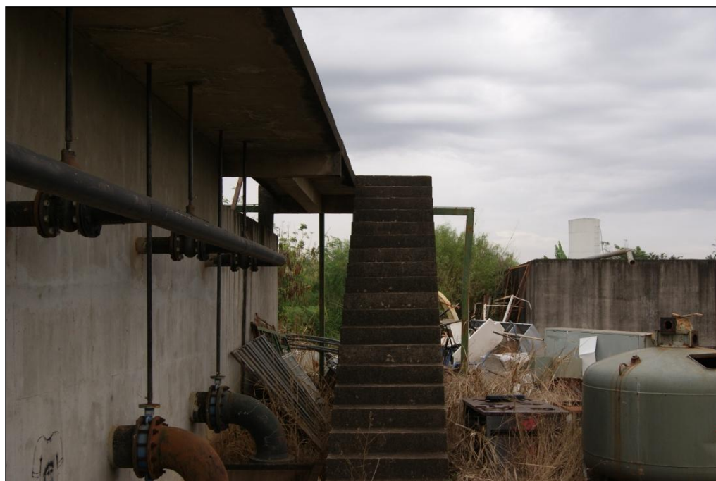
Foto 13: Acesso a parte superior da ETA. Fonte: Contatto Environmental Engenharia e Consultoria Ltda.
