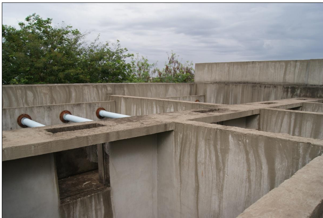
Foto 16: Vista superior da ETA.
