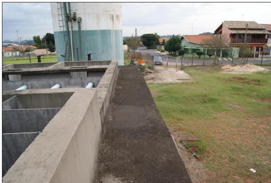
Foto 18: Vista geral da área da ETA.
