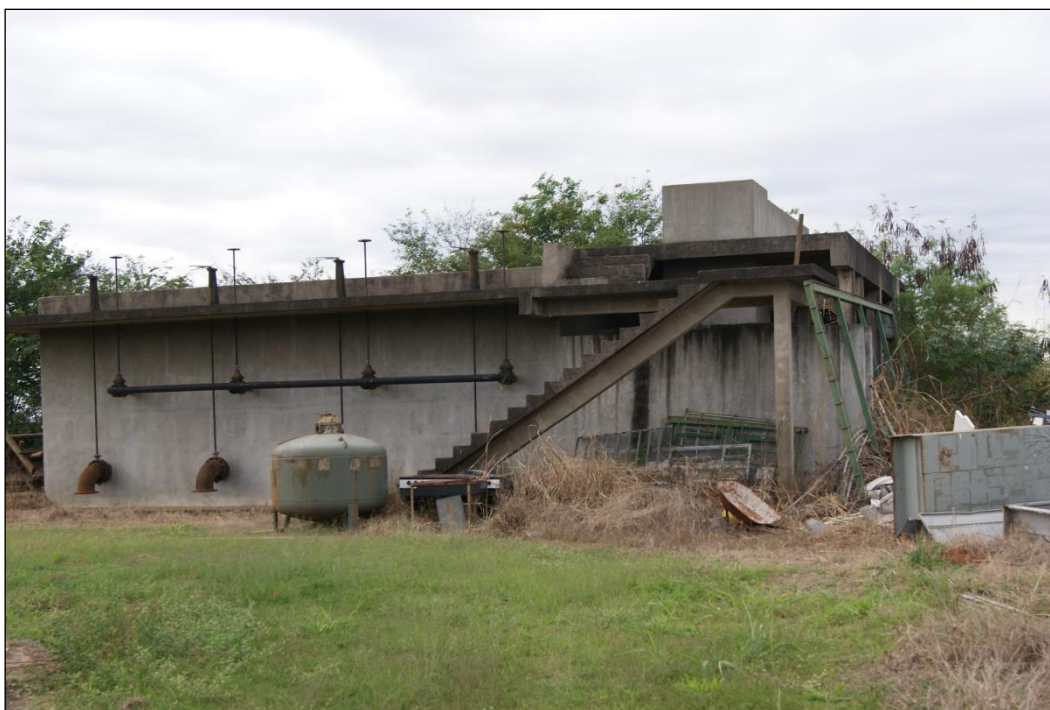
Foto 11: Vista externa da ETA.
