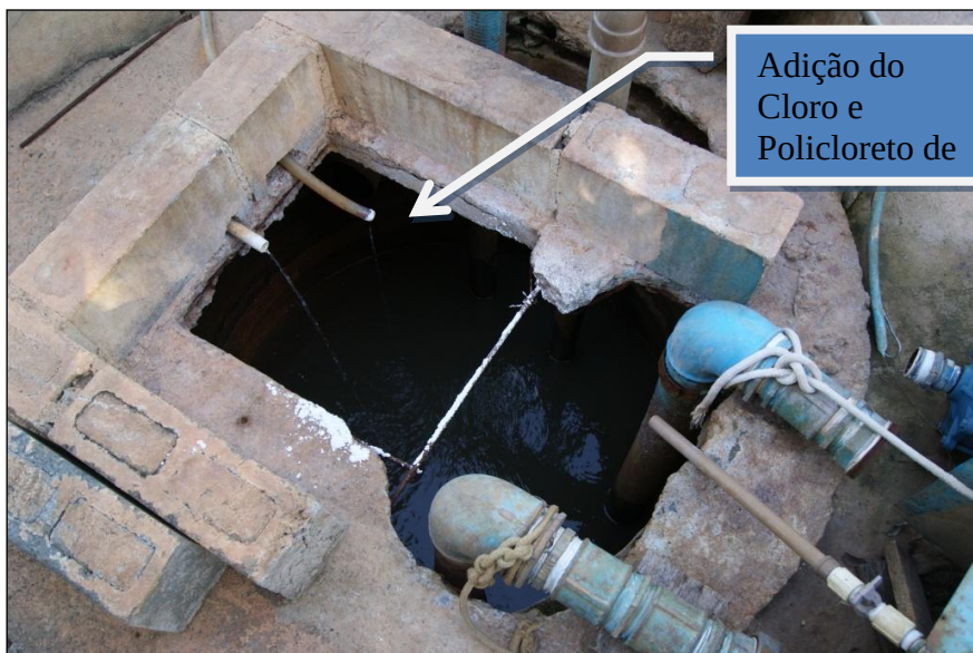
Foto 03: Local de chegada da água por gravidade. Fonte: Contatto Environmental Engenharia e Consultoria Ltda, 2013.
