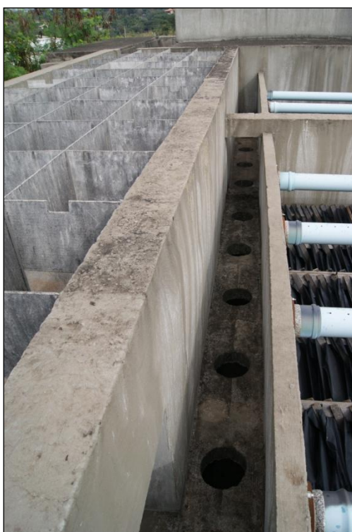
Foto 17: Parte superior da ETA.
