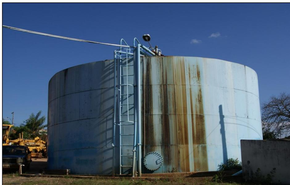
Figura 17 - Reservatório de Armazenamento e distribuição com capacidade 500 m<sup>3</sup>.
